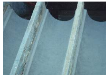
Koryta všech tří splachovacích čerpadel byla ošetřena materiálem ARC 791
