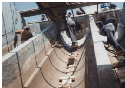
ARC 791 byl nanesen na správně připravené povrchy
