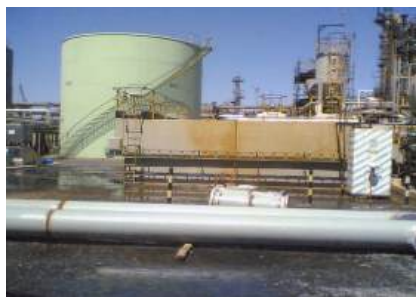
Nádrž v petrochemickém komplexu
